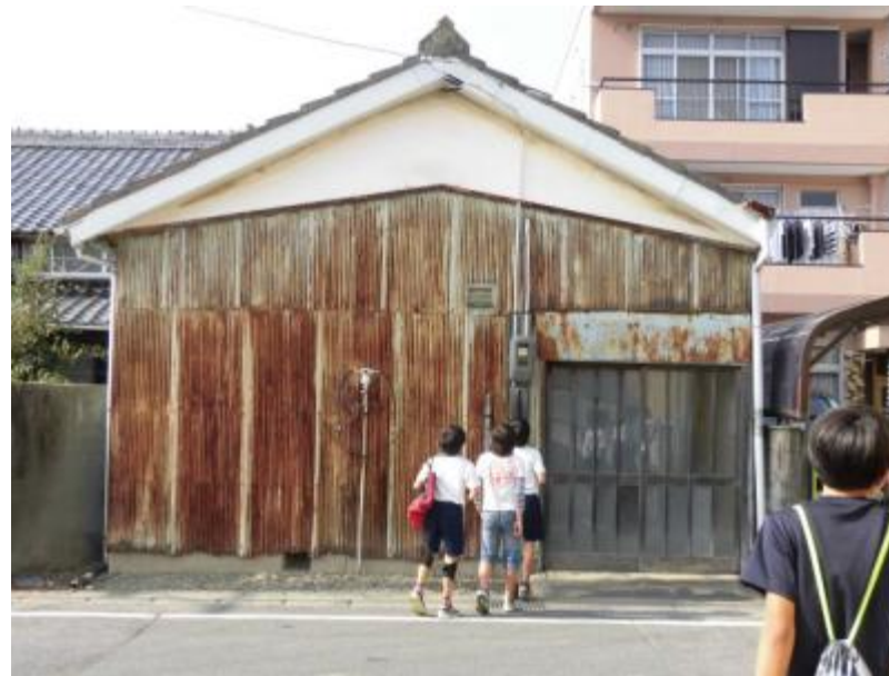
7月 避難経路を考えるための現地調査
