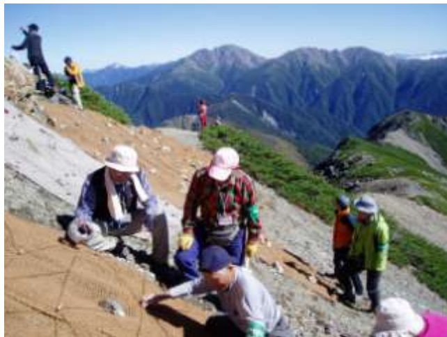
図 23 高山帯における土砂流出防止ネットの設置
