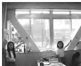
校舎を支える太い鉄骨と二重窓
