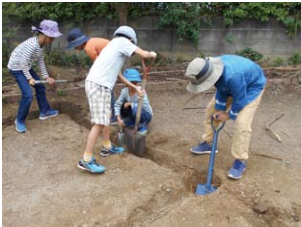
柱と壁材を立てるための穴を掘る子どもたち。
