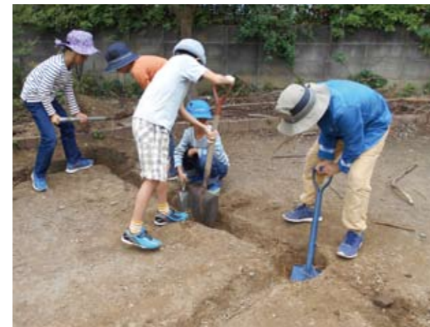
柱と壁材を立てるための穴を掘る子どもたち。
