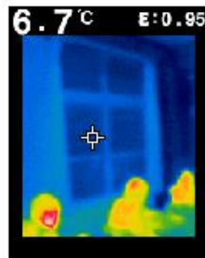
②断熱材無し教室 (外側窓)
