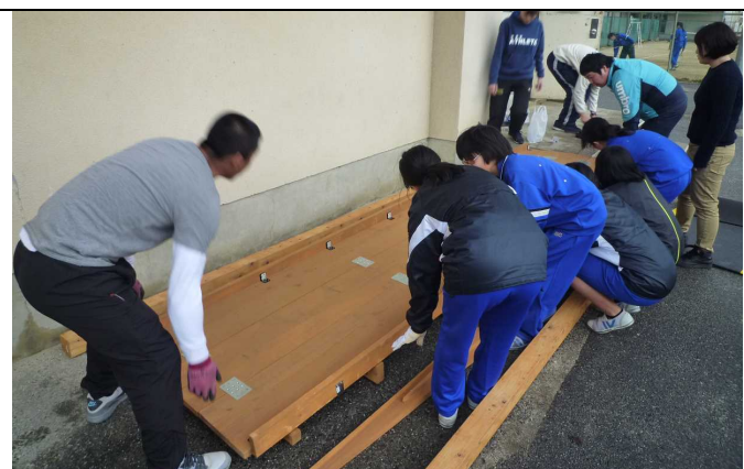
非常出口に車いす用スロープ作り
