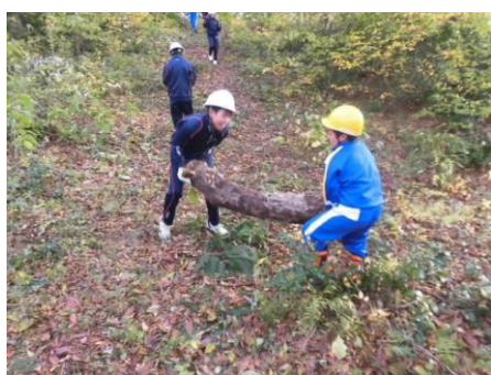
遊歩道を整備している様子
