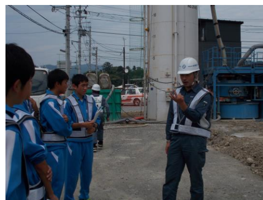
3 学年 湾岸防潮堤や道路工事視察
